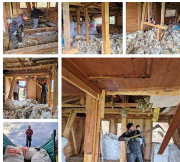
Die in die Jahre gekommene WSV-Hütte wird abgerissen.
