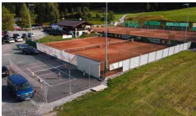
Die aufwändig generalsanierte Tennisanlage am Lauchsee in Fieberbrunn Fotos: TC Fieberbrunn
