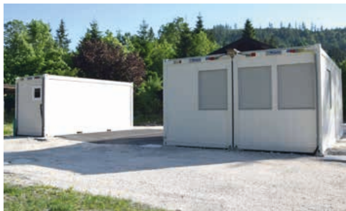
Die neue Einsatzzentrale plus Lager-Container am alten Fußballplatz wird noch überdacht. Fotos: Wörgötter
