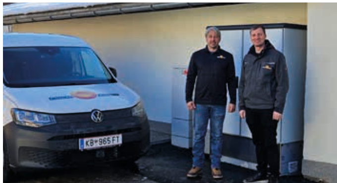
Stefan Astl, Netz- und Kundenbetreuung Außendienst und Franz Harlander, Leitung Bauprojekte und Fernwärmebetrieb, Ortswärme St. Johann
