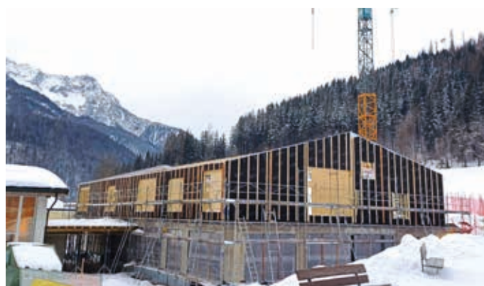
Mit Ausführung der Holzbauarbeiten nimmt der neue Kindergarten Form an. Foto: Gemeinde Waidring
