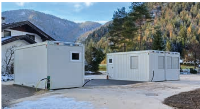
Die neue Unterkunft der Wasserrettung steht kurz vor der Fertigstellung.
