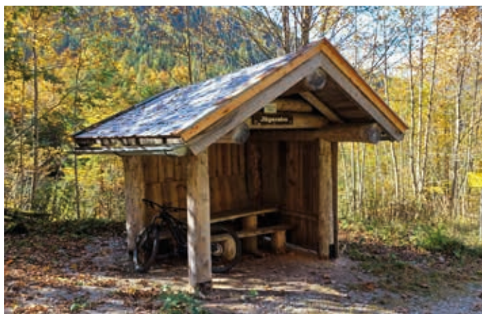
Unterstand Aschertal mit saniertem Dach.
