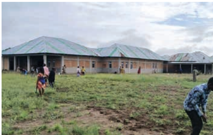
Die Eröffnung des Krankenhauses ist für Ende des Sommers 2026 geplant.
