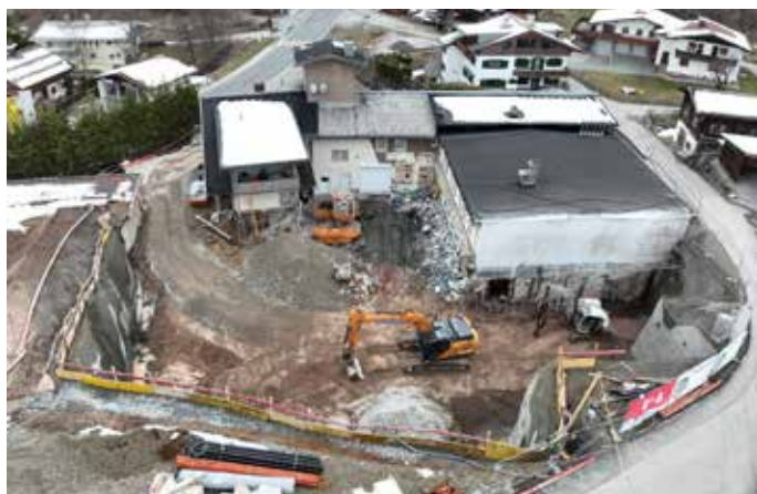
Die Baugrube am bestehenden Gebäude im Frühjahr 2026.
