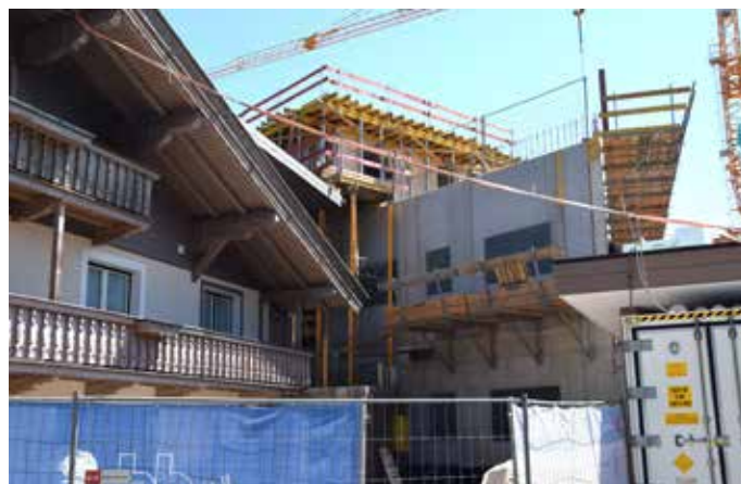
Der Rohbau steht soweit, die Arbeiten liegen im Zeitplan.
