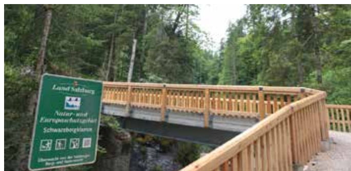
Blick auf die neue Schwarzbergklammbrücke.
