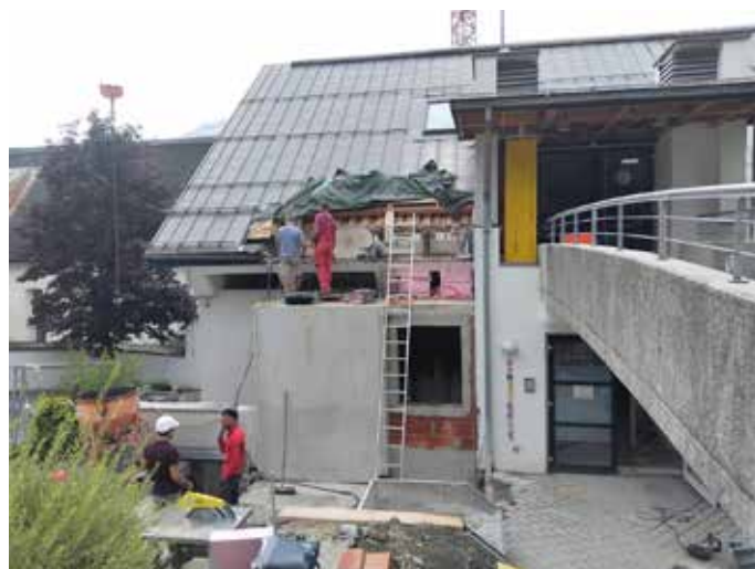
Der Umbau soll bis Ende August abgeschlossen sein.
