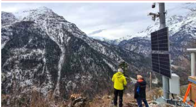
Eine Radaranlage hoch über Weißbach scannt den Hang gegenüber, erkennt Lawinen und warnt die Lawinenkommission
