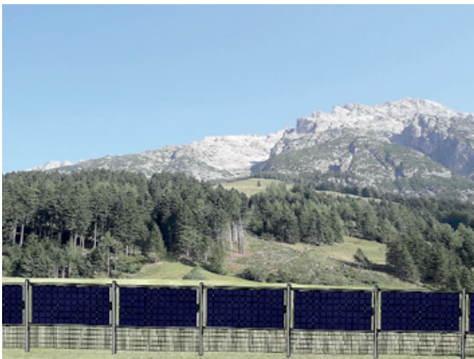
Der Zaun ist 1,50 Meter hoch, die Module liegen 0,50 Meter über dem Boden
