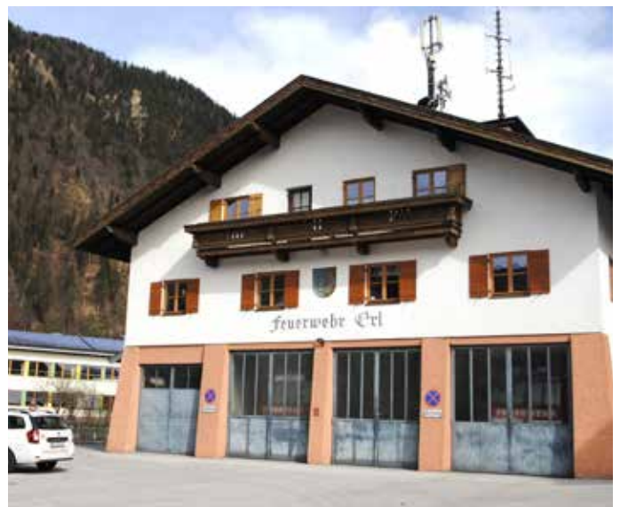
Das neue Feuerwehrhaus wird am Schwimmbadareal neu gebaut
