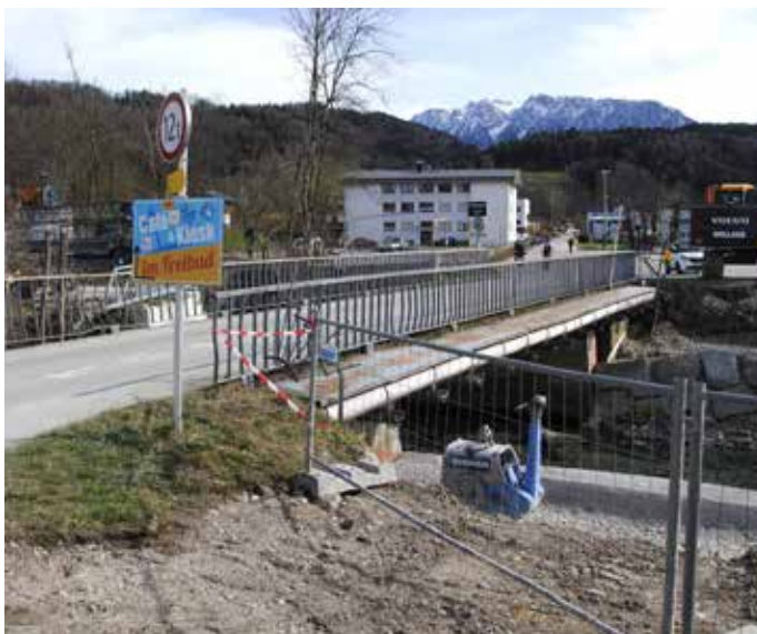
Die Brücke wird derzeit saniert und erweitert
