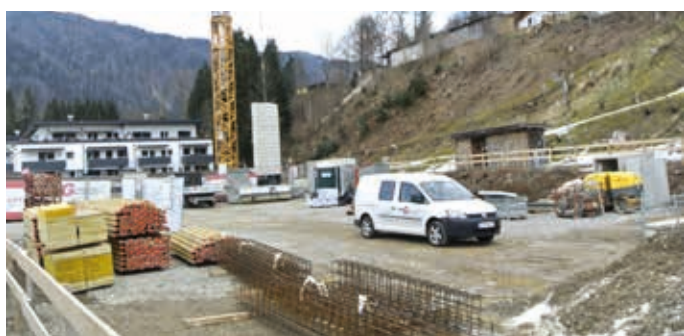
Der zweite Teil des Maurerfeldes wird derzeit bebaut.
