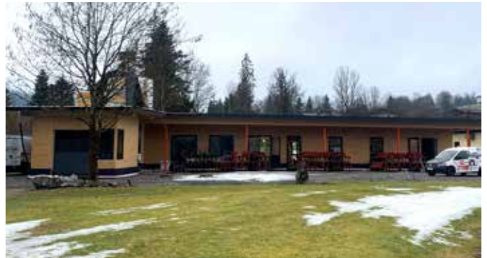
Das Gebäude beim Goinger Badesee soll bis Mai fertiggestellt sein.
