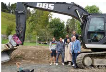
Spatenstich für das Tennisheim. Foto: Gmedia
