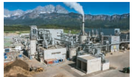
Stammwerk in St. Johann in Tirol, Brennstoffaufgabe im Vordergrund vor dem neuen Kraftwerksgebäude. Foto: EGGER
