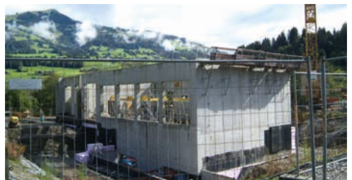
Im Herbst erfolgte der Baustart für das neue Kraftwerk im Ortsteil Elsbethen. Foto: Eberharter
