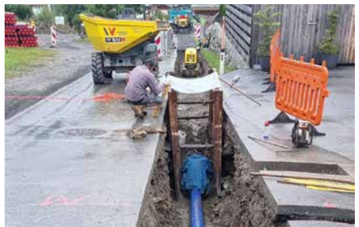
Neuer Wasserleitungsstrang zur Absicherung der Wasserversorgung
